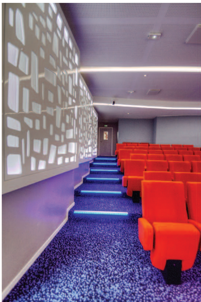
Détail des panneaux acoustiques décoratifs
