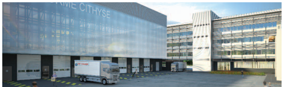
Halle technologique côté cour
